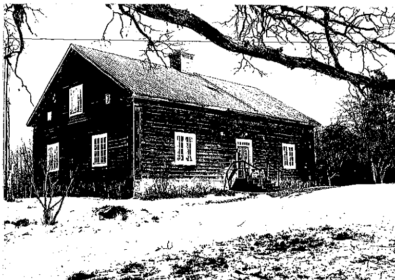
Slevringe 1:1. Gruvarbetarbostad vid Malmviken.
